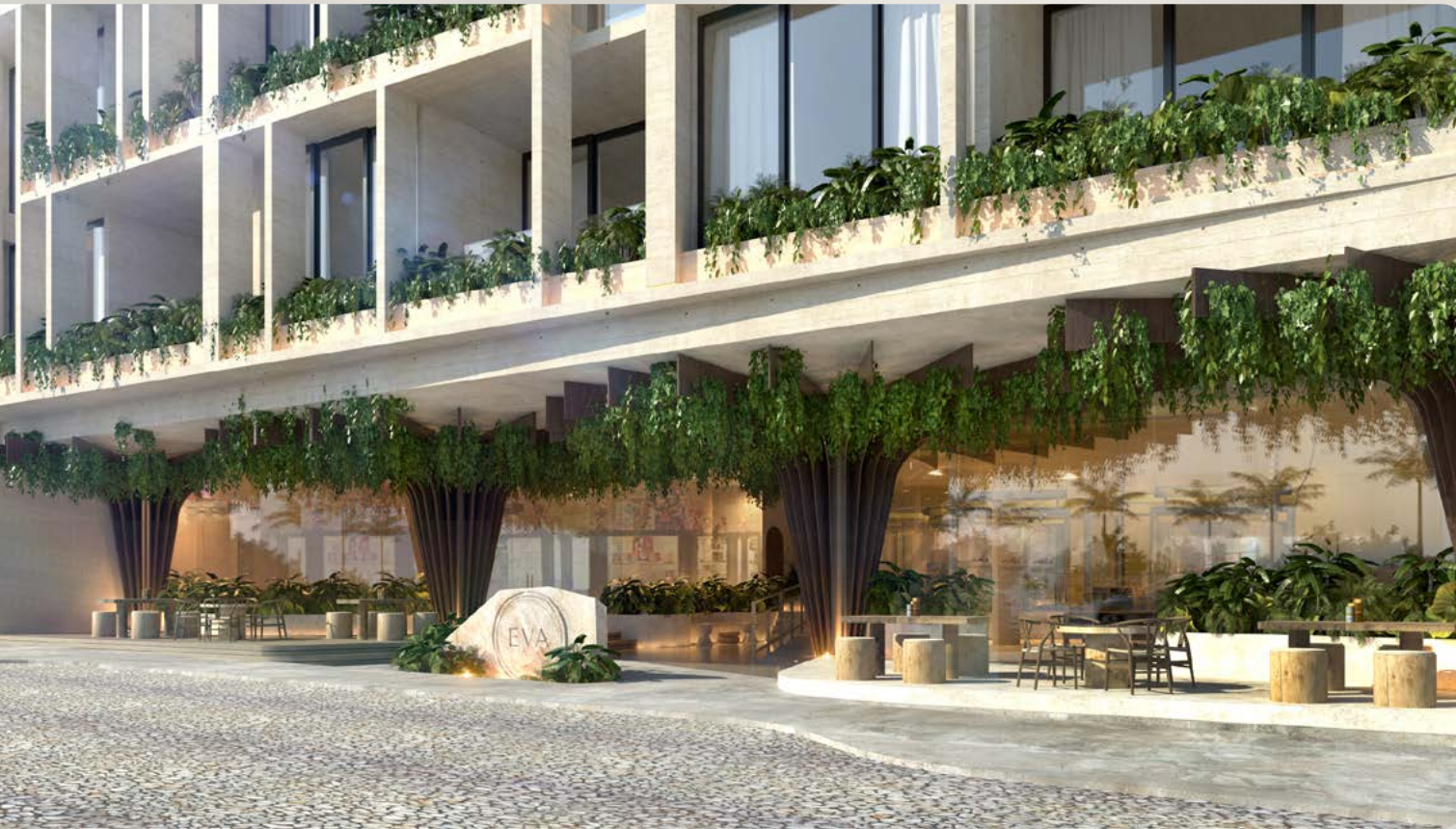
Fachada Locales 1 y 2 Calle Basilio Badillo
